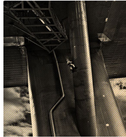
Sikkert arbeid i høyden Safe work high above the ground
